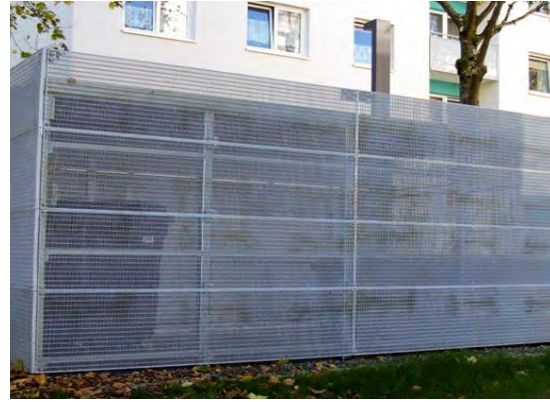
Einhausung mit Stahlverkleidung
