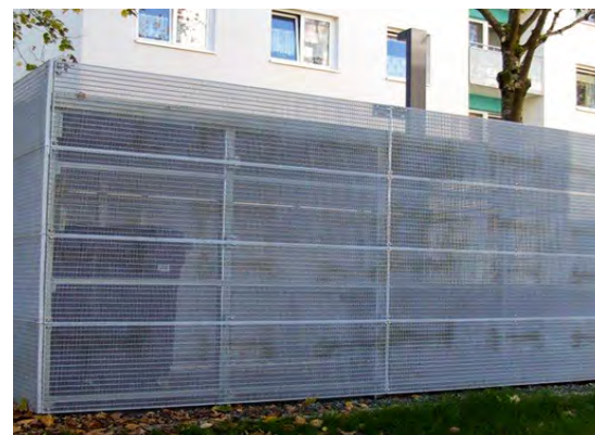
Einhausung mittels einer Stahlrostverkleidung aus Pressrostplatten, kein sichtbarer Dachabschluss, MW 30/30
